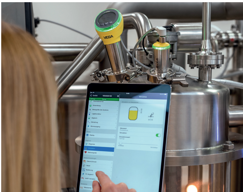
Le attività svolte dal tecnico d'impianto tramite l'app sono sincronizzate sul cloud myVEGA The tasks performed by the plant technician via the app are synchronised on the myVEGA cloud.
