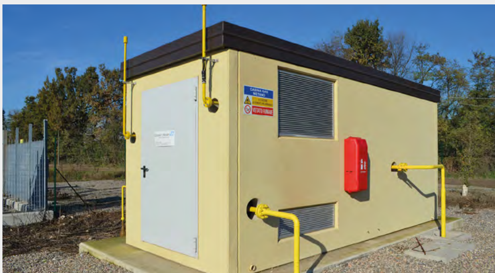
Cabina REMI di filtraggio, regolazione e misura biometano. REMI cabin for filtering, regulation and biomethane measurement.
