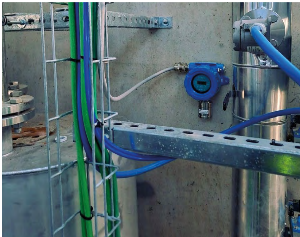
SMART 3G D2 per la rilevazione di ammoniaca durante le fasi di tintura e finissaggio. SMART 3G D2 for detecting ammonia during dyeing and finishing processes.
