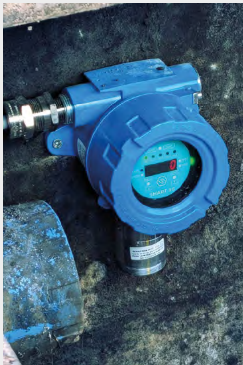
Il rilevatore SMART 3G D2 impiegato nel reparto di tintura con CO 2 supercritica.
