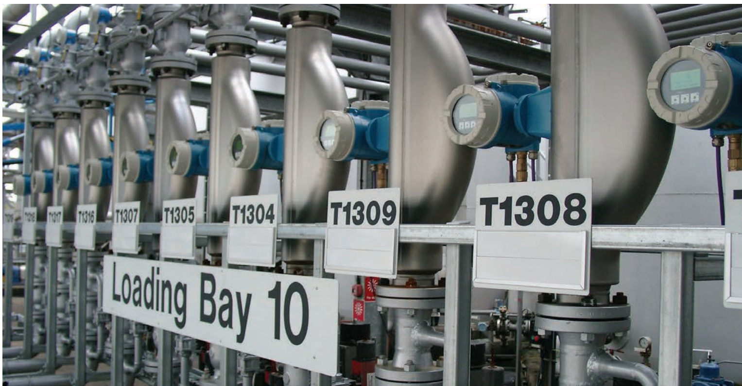
I misuratori di portata massa Coriolis misurano direttamente la portata massa con elevata precisione. Coriolis mass flow meters measure mass flow directly with high accuracy.
